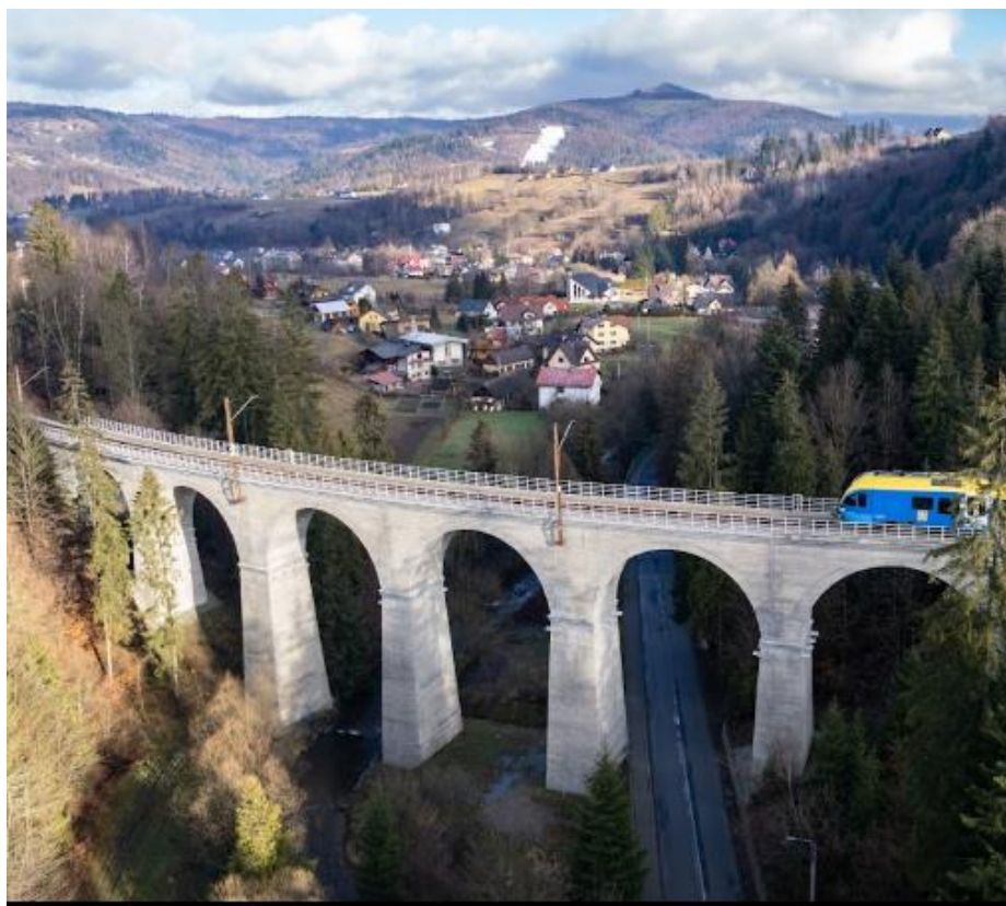
Fotografia 3. Widok na wiadukt kolejowy w Wiśle Łabajowie.
