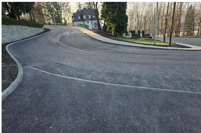
ul. Górnośląska po modernizacji
