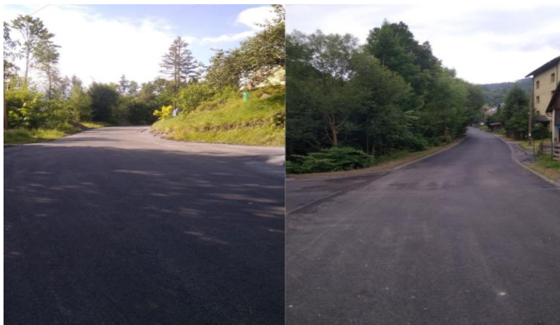
ul. Cieślarów oraz ul. Sportowa po modernizacji
