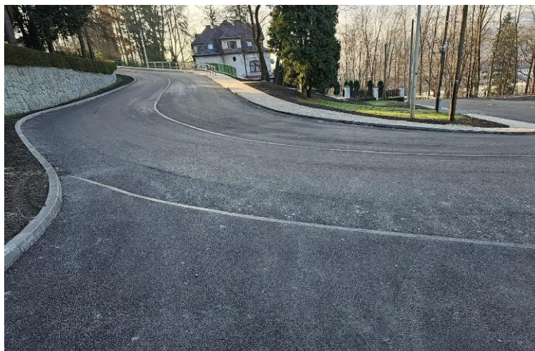
ul. Górnośląska po modernizacji
